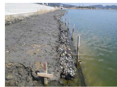
泥質土の撒きだし、 ネット蛇籠の敷設
