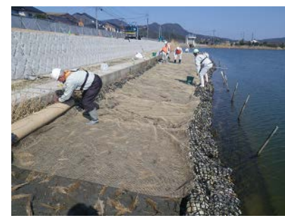
植生ネットを敷設
