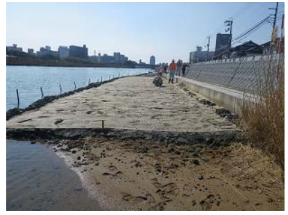
竹串により植生ネット を固定
