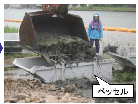
基盤のベッセルへの移し入れ
