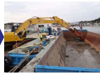
土運船へ移し入れ
