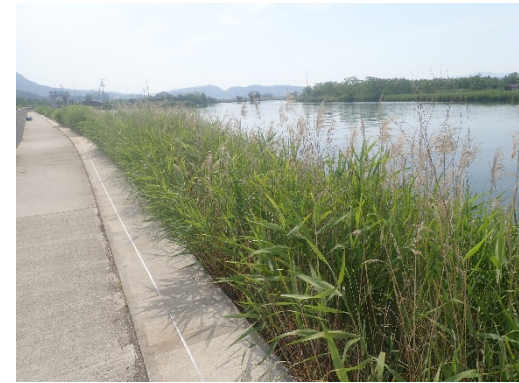
調査地概況: 下流側 (R2.6)
