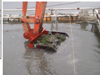
移植先へ基盤を 設置
