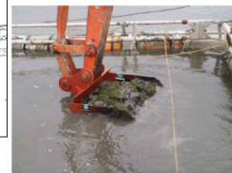
移植先へ基盤を 設置
