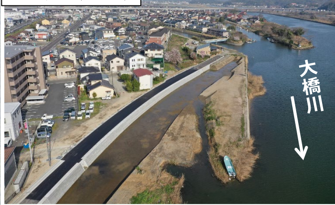
工事完成(R3.10)
