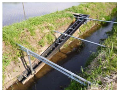
水田魚道の設置により、落差の生じた水路と水田の連続性を確保 資料) 水田魚道づくりのすすめ(農林水産省)
