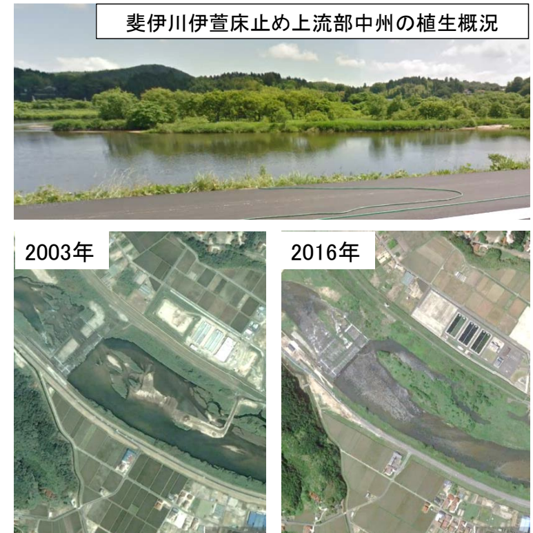
伊萱床止め上流部中州の植生の遷移状況
