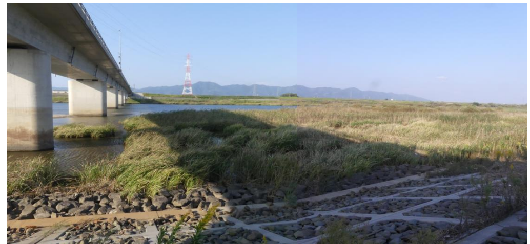
右岸より確認(2018/10/18)
