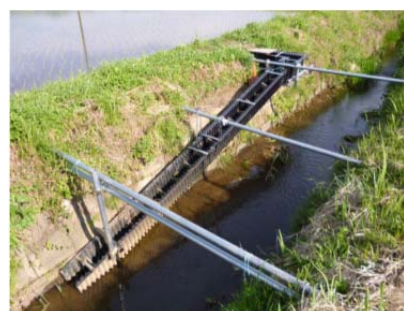
水田魚道の設置により、落差の生じた水路と水田の連続性を確保 資料) 水田魚道づくりのすすめ (農林水産省)
