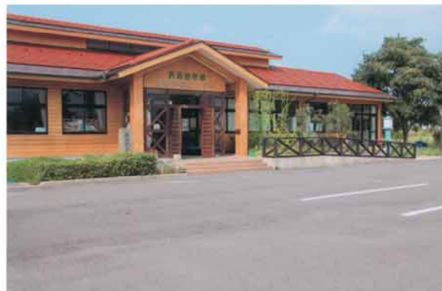
● 浜遊自然館・出雲学習センターの外観
