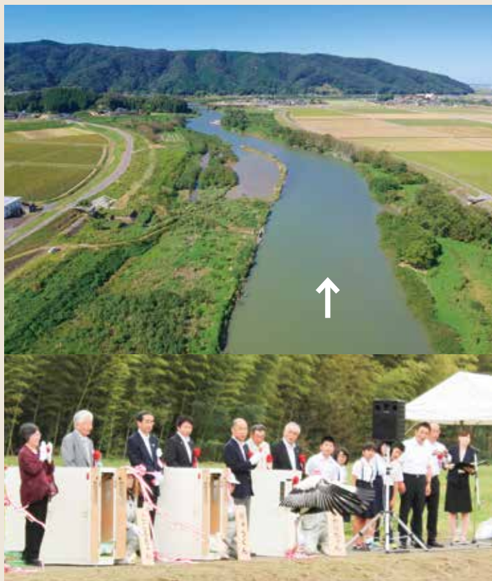
上. 日野川片粕地区(平成30年8月竣工)の施工例
