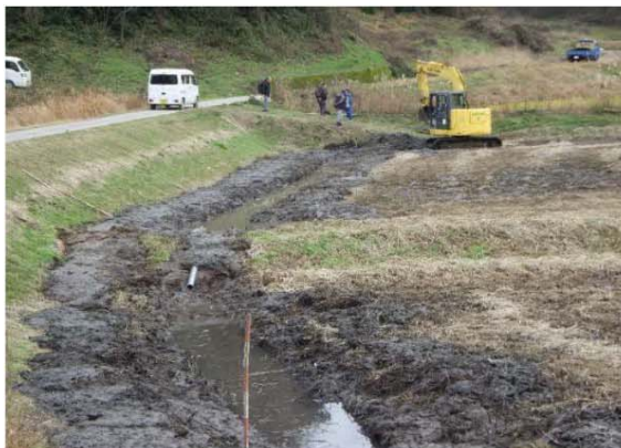
重機による水路整備状況（R5,12,19）
