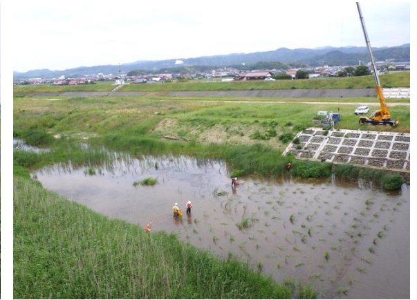
施行直後(平成28年6月)
