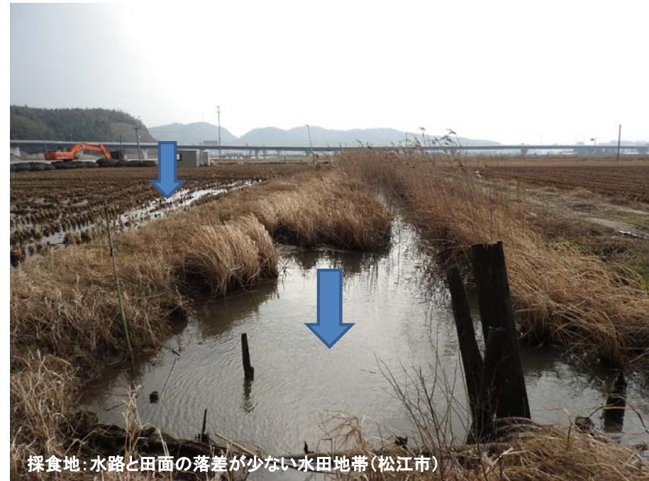
水路と田面の落差が少ないと(矢印)、年間を通して水田内に水たまりが形成、保残されやすい。また、水田と水路との水生生物の行き来が比較的容易になっている。
