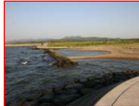
水上スポーツが楽しめるよう配慮した潜堤 カヌー等の水上スポーツが楽しめるように、 潜堤の両端は水深を確保
