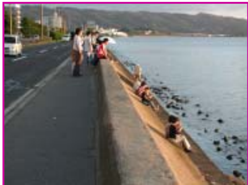
護岸 歩行スペースが無く、水面近くまで降りることが 困難であり、親水性に乏しい
