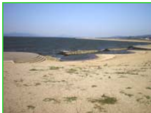
砂浜の保全のための開口部 砂浜への湖水の循環に配慮 砂の流出を防止するための離岸堤を設置
