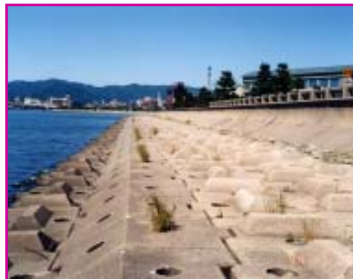
高さ1m程度のコンクリート性のパラペット構造の湖岸堤 水辺と公園が遮断 宍道湖を眺めるときにも護岸が障害
