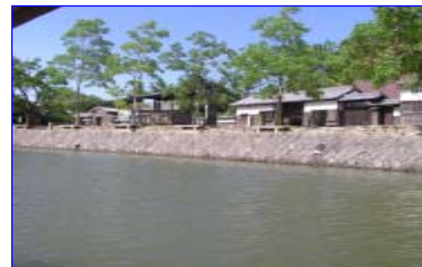
城下町の風情に合わせた石積護岸 歴史的経緯を踏まえた石積護岸
