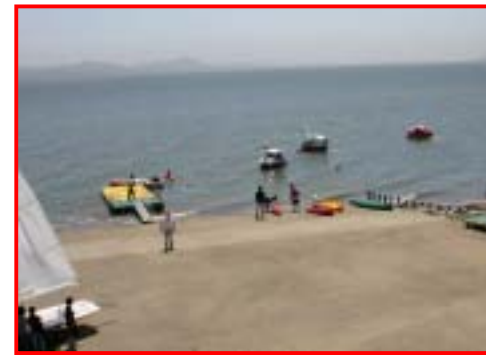
マリンスポーツの拠点 艇庫の護岸をヨットやカヌーを使用しやすい よう幅を20m確保したマリンスポーツ斜路
