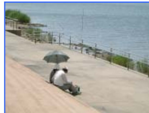
水辺に親しめる階段護岸 スムーズに利用できるよう配慮した 階段護岸
