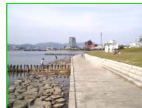
自然材料使用・生態系への配慮 水際遊歩道は自然石（みかげ石）を使用 空隙構造で、生物が生息しやすい環境
