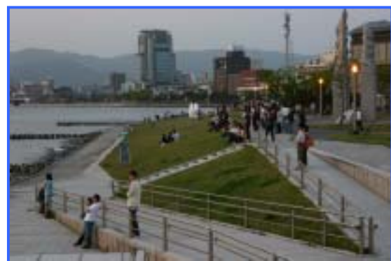
市民のための親水（出入り自由の広場） 自然の土手をイメージした緩勾配の張芝護岸 自然石を使った階段やスロープ スロープには広い踏み場を設け、身体障害者 対応の手すりを設置
