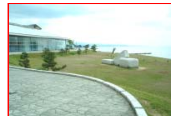
美術館と一体利用 芝生エリアに彫刻を配置、松を植え自然な風景を創造し、 美術館の前庭として位置づけ 美術館からみて芝から自然に水面へとつながるよう張芝 護岸の勾配を工夫
