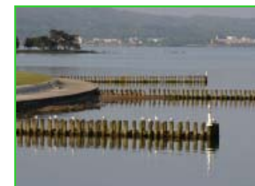
突堤 松杭+捨石という宍道湖の伝統的工法
