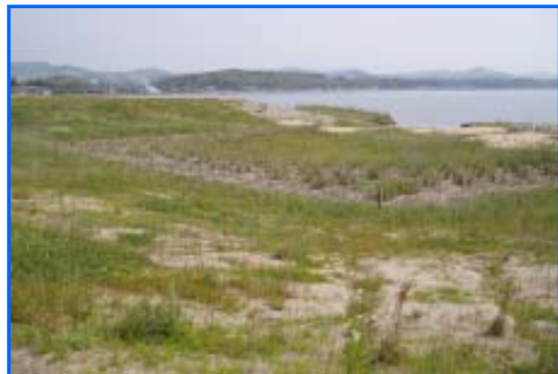
治水安全度を確保 引堤にすることで、緩勾配(1:10)の堤防 水辺に近づきやすく、親水性の高い空間
