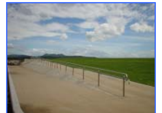
車椅子の利用に配慮したスロープと遊歩道 車椅子が水辺に近づけるように配慮 スロープ勾配5.0%
