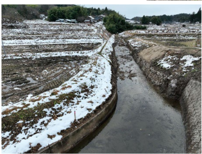
堆積土砂撤去後
