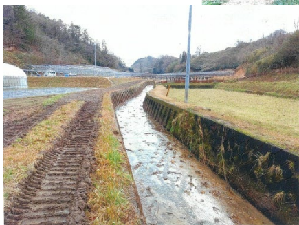
堆積土砂撤去後
