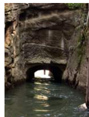
来原岩樋(来原高瀬川の取水口として1700年完成)
