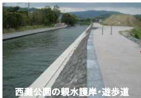
西瀬公園の親水護岸・遊歩道
