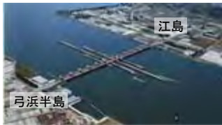
撤去工事前の中浦水門
