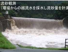
平成18年7月出水時の日登堰堤からの越流状況 ※鳥根県 雲南県土整備事務所 提供
