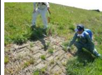
護岸等の機能維持のための堤防点検
