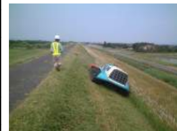
堤防の変状を把握するための堤防除草
