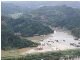
写真 2-7 出雲市船津町の浸水状況
