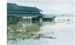
写真 2-4 斐川町の浸水状況
