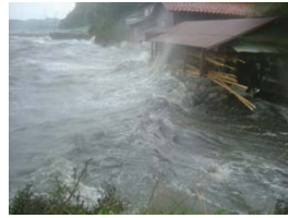
写真 2-6 松江市大海崎町の浸水状況 (平成 16 年 9 月)
