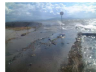
写真 2-5 米子市霞津の浸水状況 (平成 15 年 9 月)
