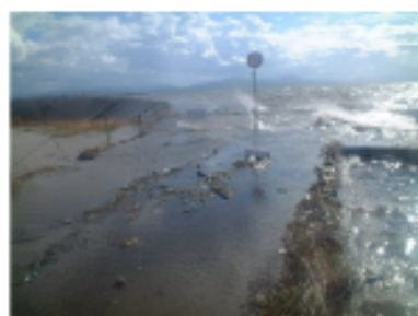
写真 2-5 米子市霞津の浸水状況 (平成 15 年 9 月)
