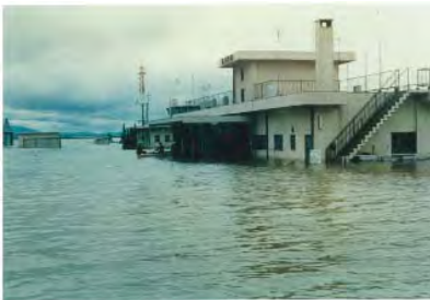
写真 2-1 出雲空港の浸水状況(10日間閉鎖)
