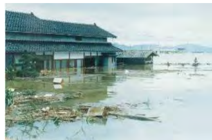
写真 2-4 斐川町の浸水状況
