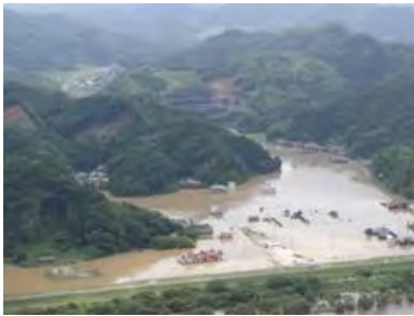
写真 2-7 出雲市船津町の浸水状況
