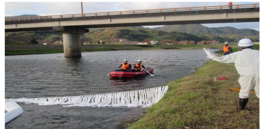
ボートによるオイルフェンス展張
