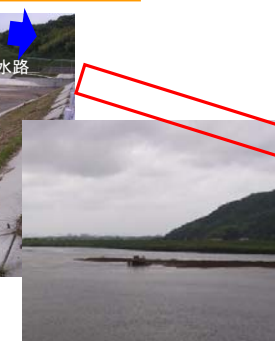
撤去の状況(敷き均し)
