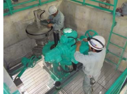
放流設備の点検
