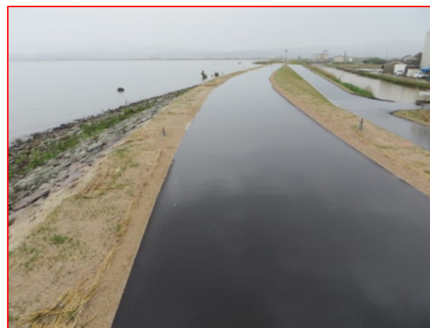
H27試験盛土状況
