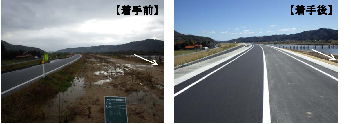
上出西地区整備状況17.6k付近
