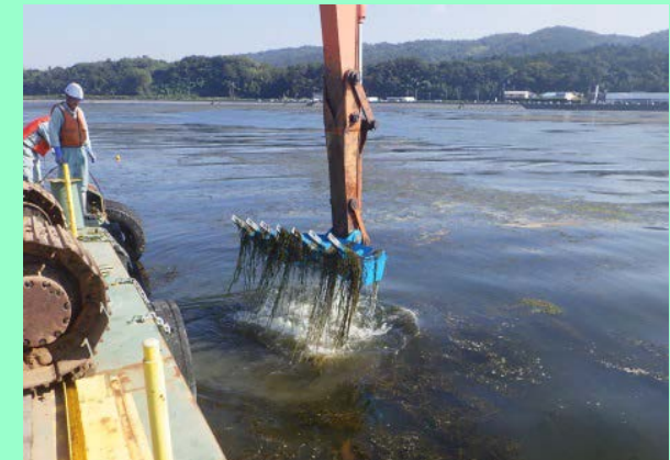
【台船＋バックホウ(スケルトンバケット)を用いた試験施工】
