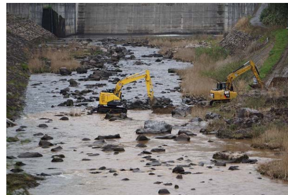
【土砂投入の実施状況】
