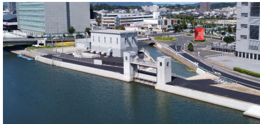
上追子川排水機場
