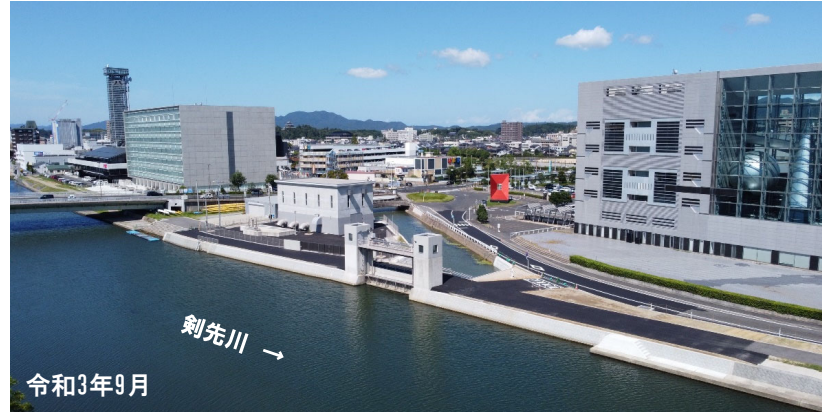
【上追子川排水機場】
