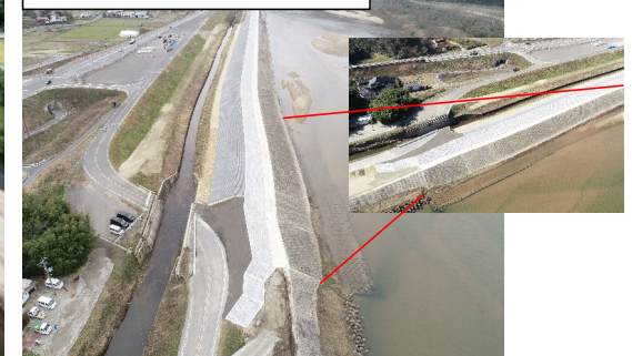
【H31. 3工事施工後】
