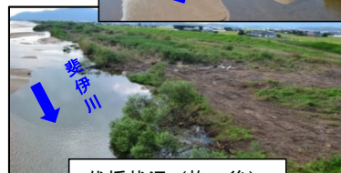
伐採状況 (施工後)
