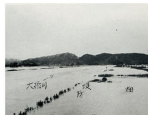
大橋川中流部氾濫状況
