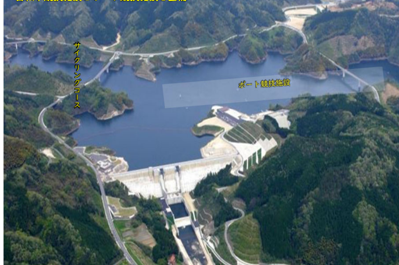
ダム建設に合わせて自転車競技施設とボート競技施設を整備
