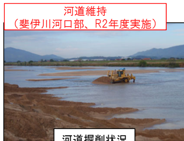
河道掘削状況
