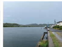
現在の様子 大橋川 中流部氾濫状況
