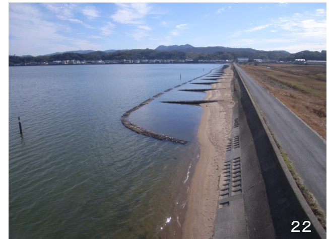
施工直後 (H22.1)
