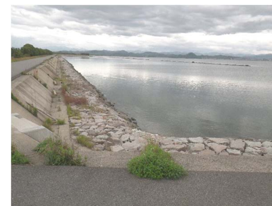
施工後の状況 (H24.5)
