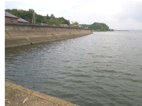
調査地区の状況（H25年6月）
