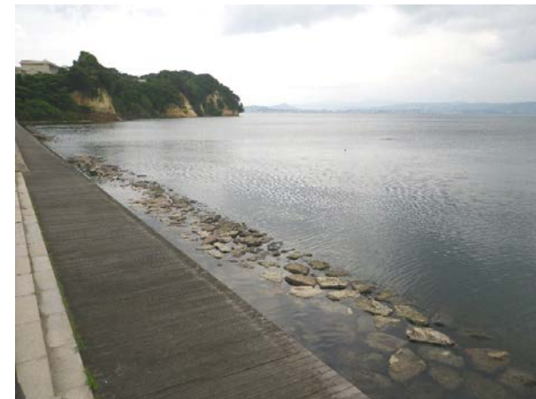
調査地区の状況（H25年6月）
