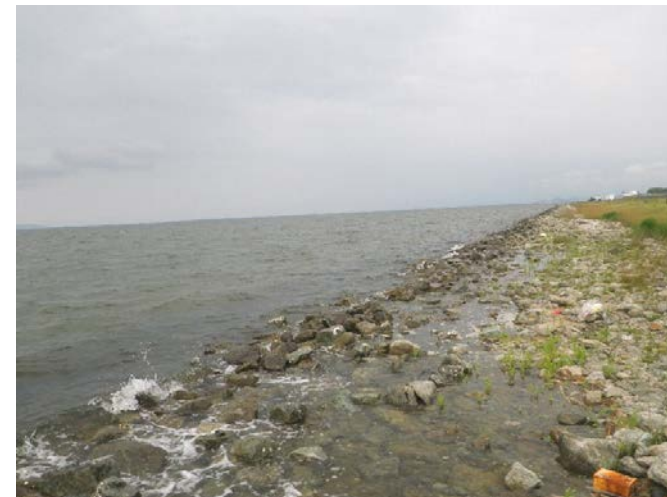
調査地区の状況（H25年6月）
