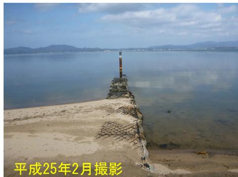
漂砂防止堤の効果が発揮され、漂砂が遮断されている
