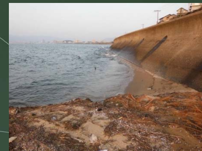
端部突堤を越えて系外に流出する土砂
