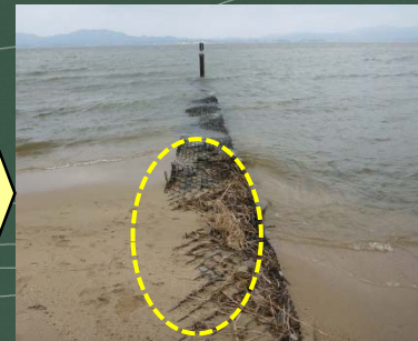
漂砂防止堤の天端を乗り越える土砂
