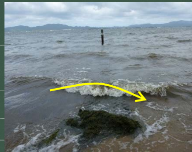
漂砂防止堤の天端を乗り越える土砂
