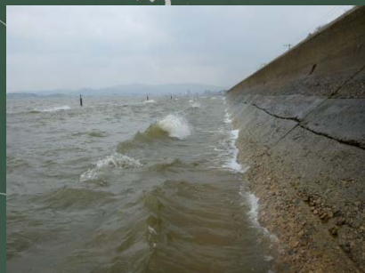
基盤が流出し後退した湖岸
