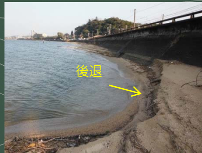
基盤が流出し後退した湖岸
