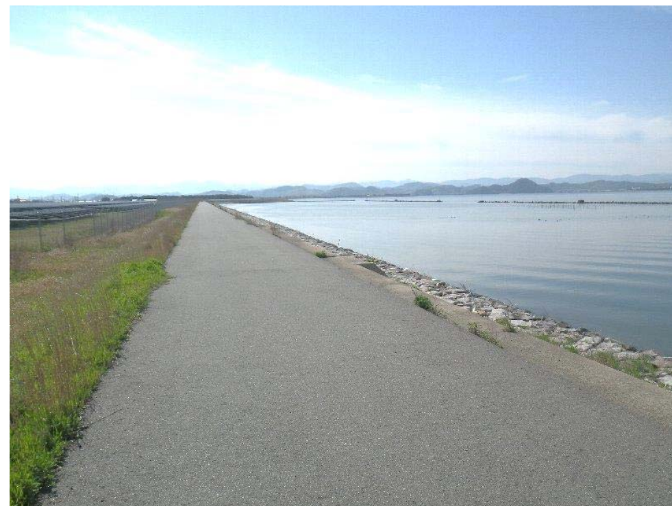
調査地区の状況（H27年4月）
