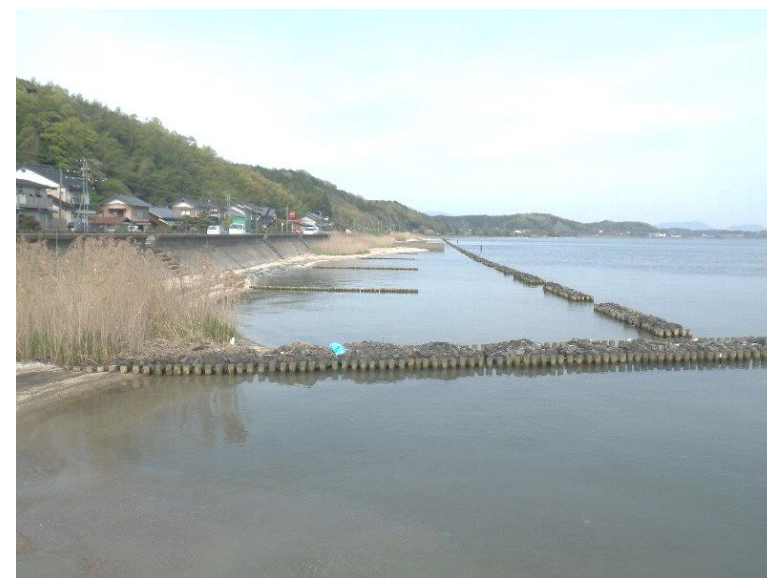
調査地区の状況（H27年4月）
