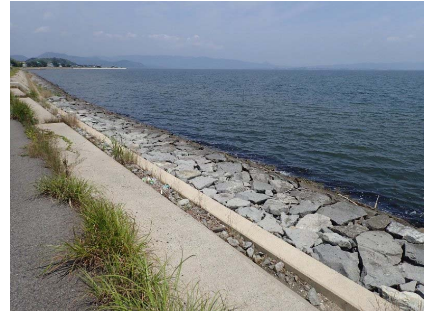
調査地区の状況（H27年7月）
