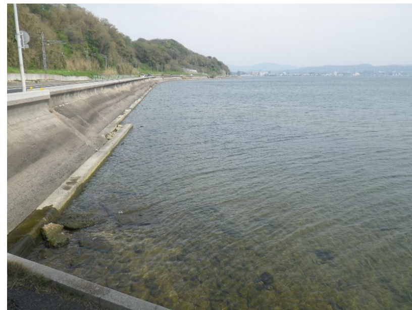
調査地区の状況（H27年4月）
