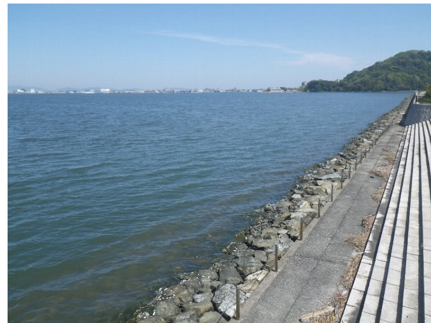
調査地区の状況（H27年4月）
