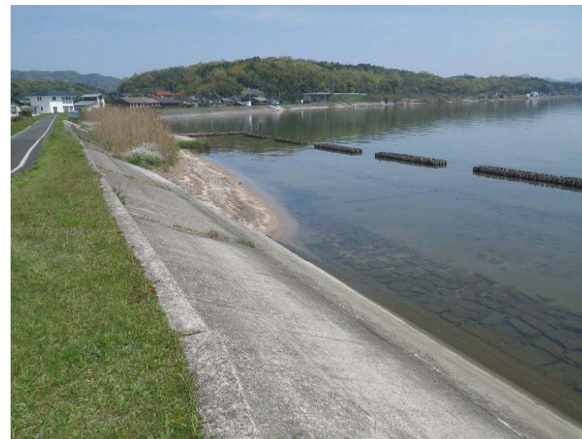
調査地区の状況（H27年4月）
