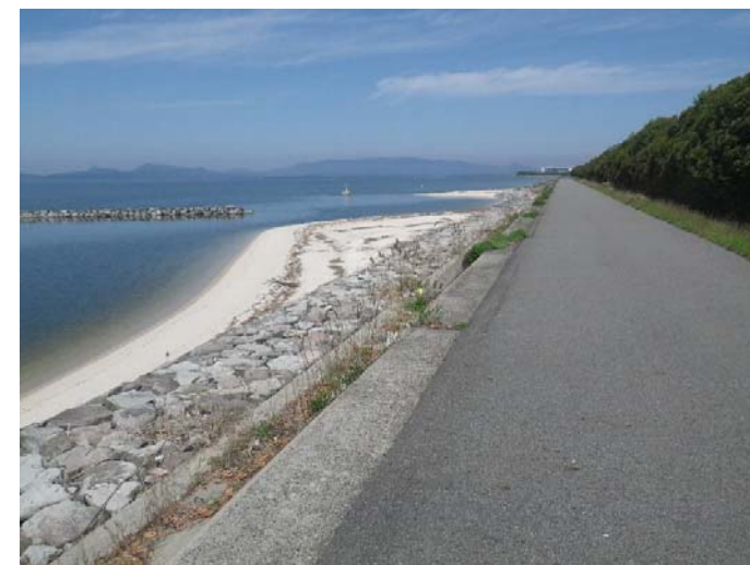
調査地区の状況（H27年4月）
