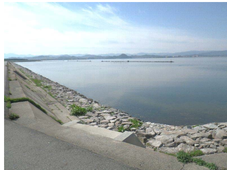
調査地区の状況（H27年4月）
