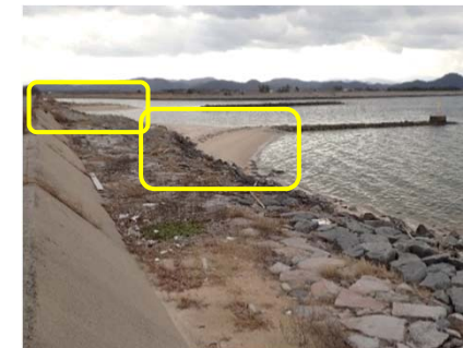
地区南端突堤と離岸堤岸側の砂州 (H29年12月20日)
