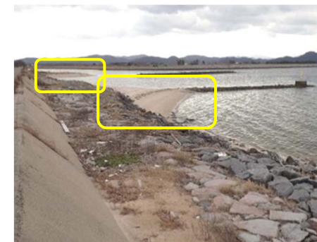
地区南端突堤と離岸堤岸側の砂州 (H29年12月20日)
