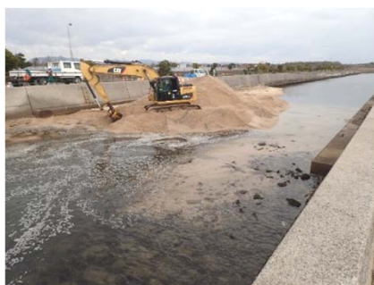
承水路の浚渫の状況 (H29年12月20日)
