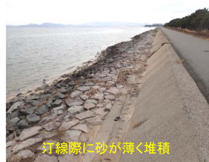
浅場整備箇所の状況 (H29年12月20日)
