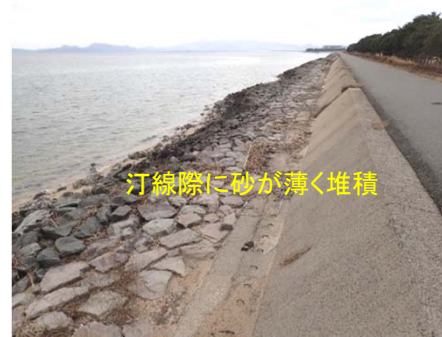
浅場整備箇所の状況 (H29年12月20日)
