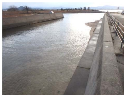
承水路の浚渫後の状況 (H30年1月4日)
