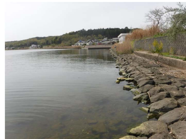
調査地区の状況（H30年4月）
