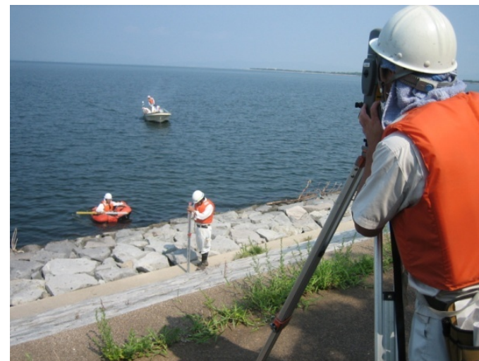
基盤調査の状況
