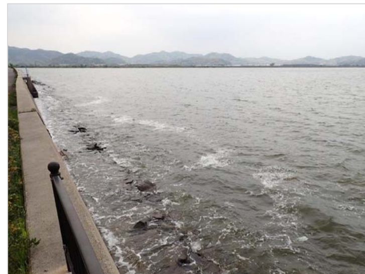
調査地区の状況（H30年5月）
