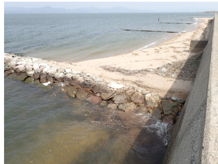
調査地区の状況（H30年4月）
