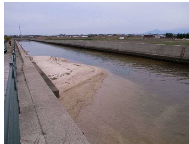
承水路状況（平成31年2月）
