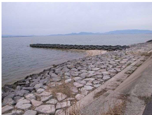
南端突堤付近状況（平成31年2月）
