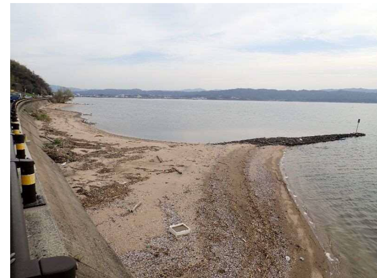
調査地区の状況（平成31年3月）
