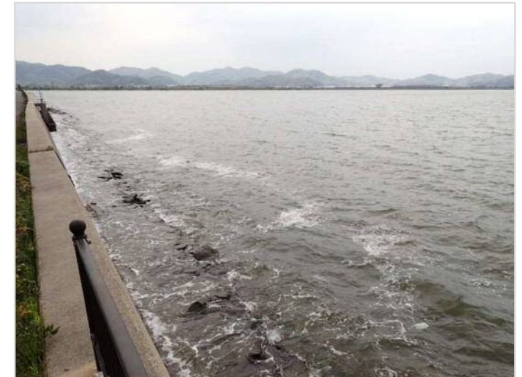
調査地区の状況（平成30年5月）
