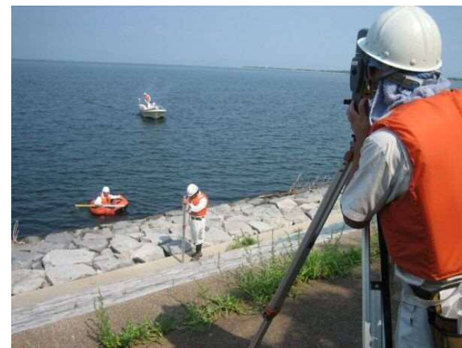
基盤調査の状況
