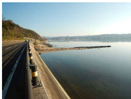
施工後 (R1年11月)
