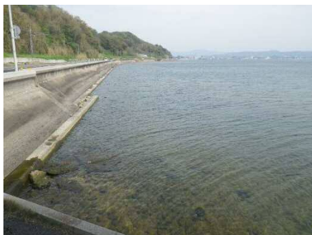
施工前 (H27年4月)
