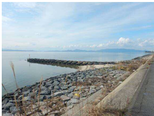
南端突堤付近状況（令和2年1月）
