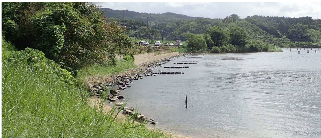
施工前 (R1年9月)
