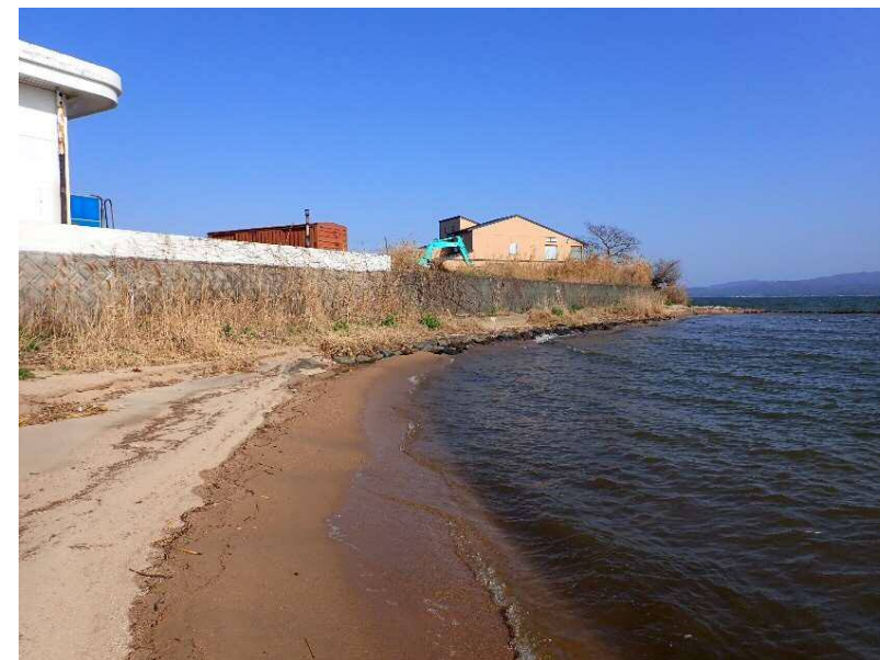
調査地区の状況（令和3年3月）
