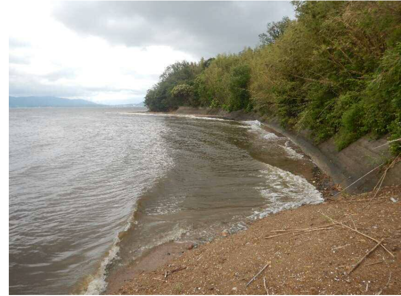
調査地区の状況（令和3年5月）
