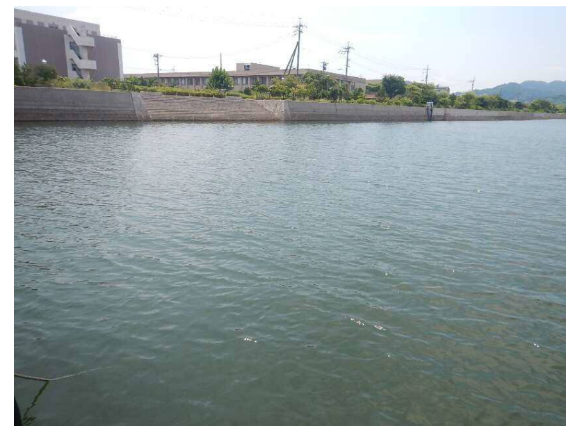
調査地区の状況（令和3年8月）
