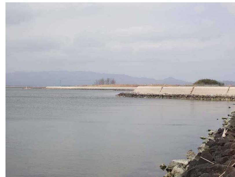
調査地区の状況（令和3年3月）
