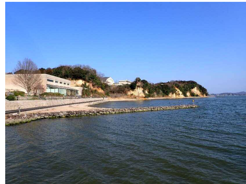
調査地区の状況（令和3年3月）
