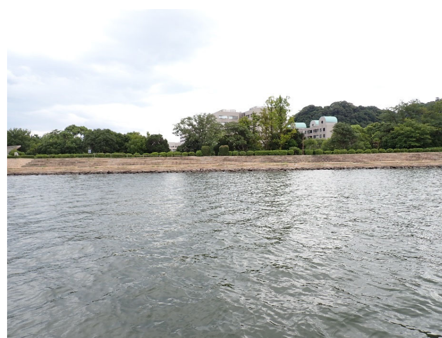
測点13の状況（令和4年8月）
