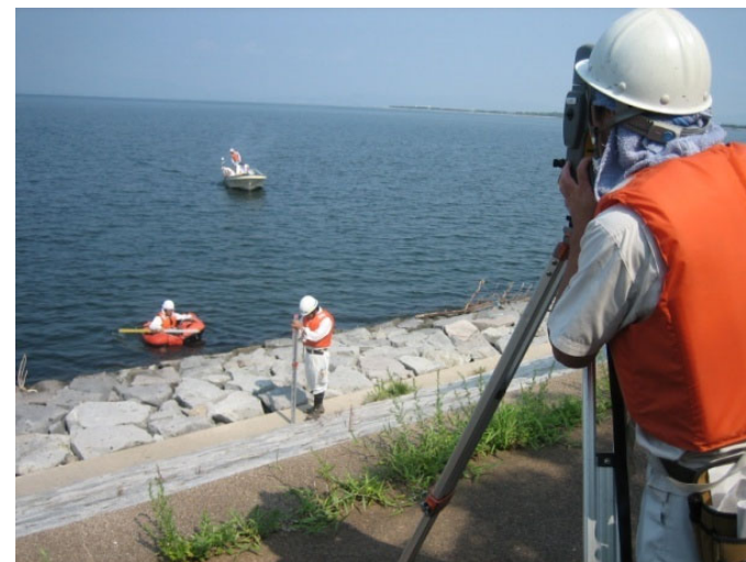
深浅測量の状況
