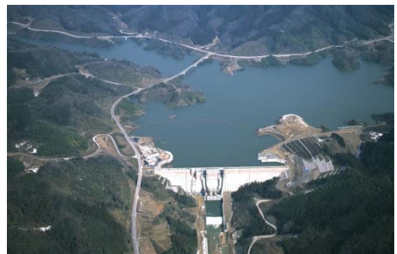
写真－２ 尾原ダム
