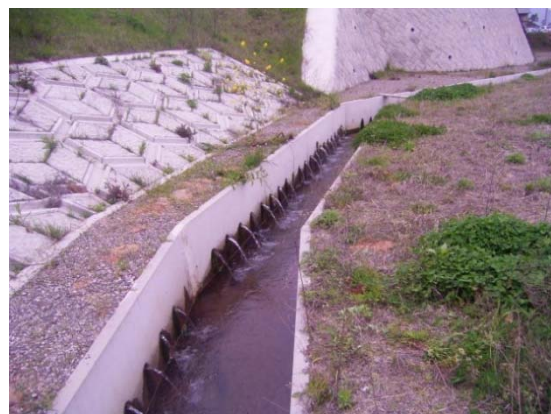
写真－７ ドレーン工排水状況
