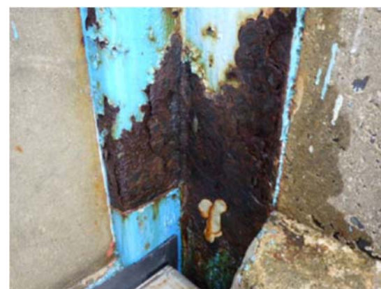
写真－１０ 塩害による戸当り発錆腐食状況
