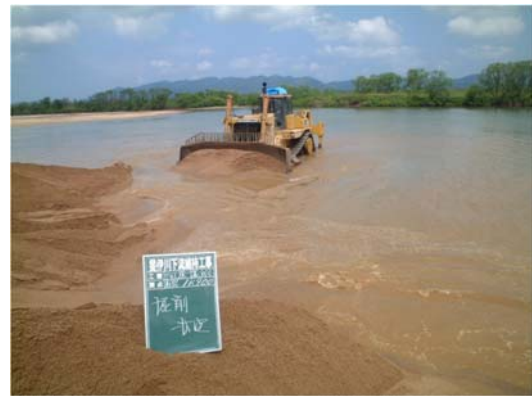
写真－５ 維持掘削状況 (斐伊川本川 2k 付近)
