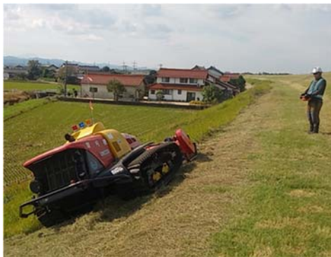
写真－２２ 堤防除草作業
