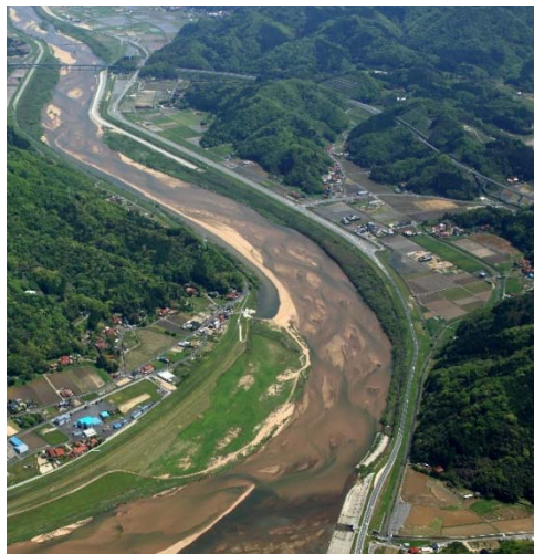
写真－１２ 支川合流部の導流堤(斐伊川本川 20k 付近)
