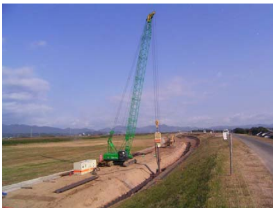
写真－６ 堤防の耐震対策工事
