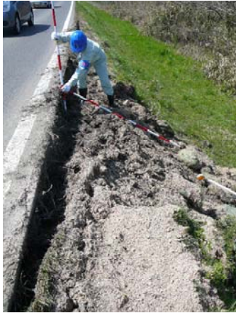
写真－１９ 堤防点検の様子
