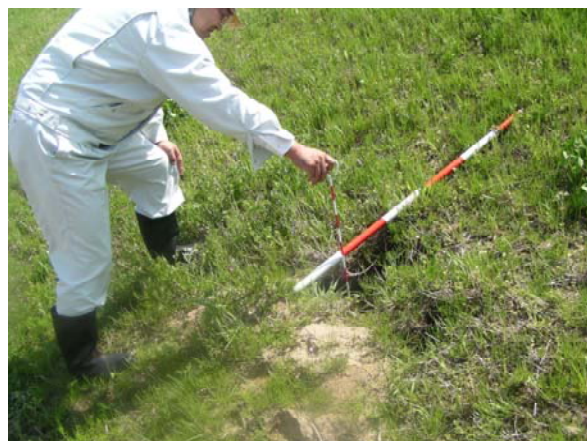
写真－24 除草後に確認された変状
