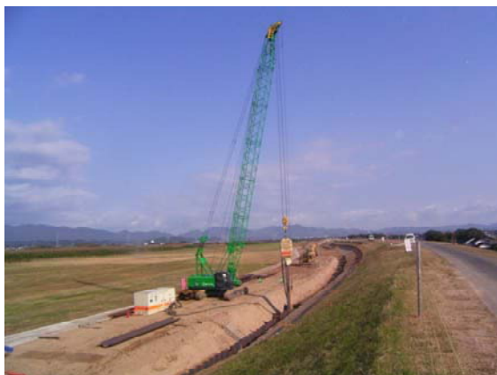
写真－６ 堤防の質的強化工事
