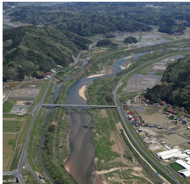
写真－ 1 2 支川合流部の導流堤(斐伊川本川 20k 付近)
