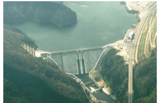
写真－2 志津見ダム
