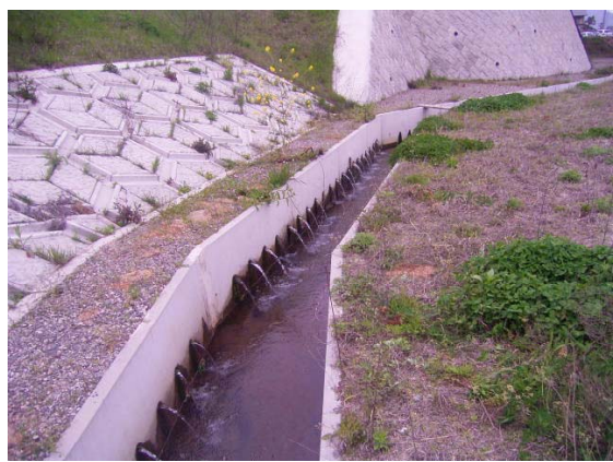
写真－７ 裏石張り排水状況
