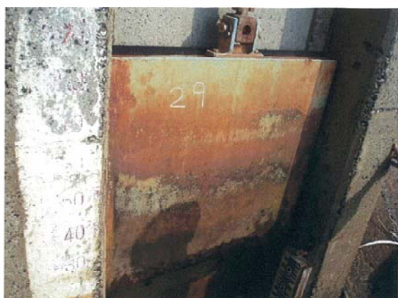
写真-10 発錆による扉体腐食状況
