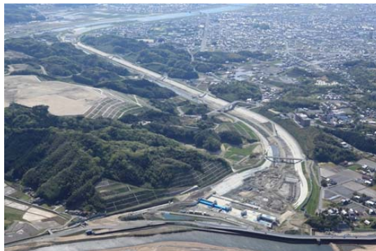
写真－3 斐伊川放水路（分流地点から下流を望む）
