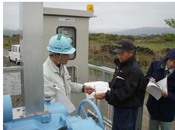
写真－２７ 排水門の操作方法の説明
