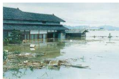
写真 2-4 斐川町の浸水状況
