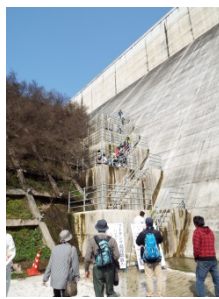
フーチング階段から ダム上を目指す
