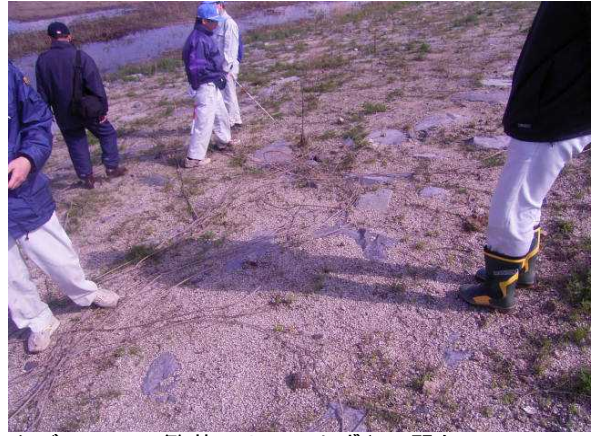
大型石積みの護岸、坂路の間詰め土砂の流出によるクズ(ツル)の繁茂によるつまずきの恐れ 窪み、隙間の発生
