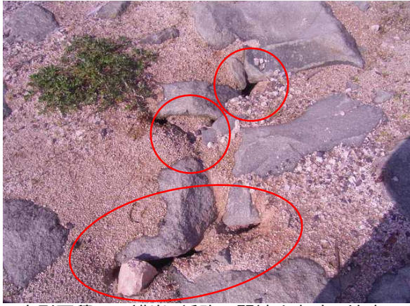
大型石積みの護岸、坂路の間詰め土砂の流出によるクズ(ツル)の繁茂によるつまずきの恐れ 窪み、隙間の発生
