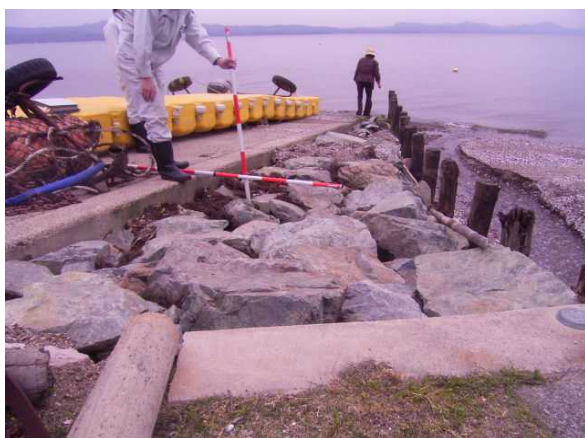
捨て石工の沈下、流出
