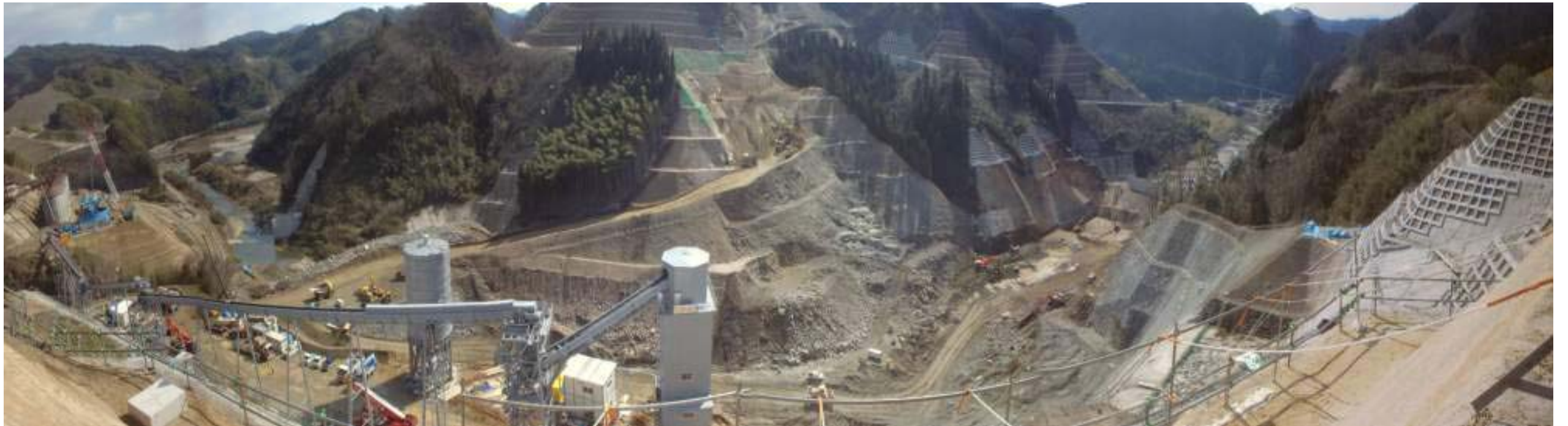
ダム本体掘削状況(右岸より左岸を望む)
