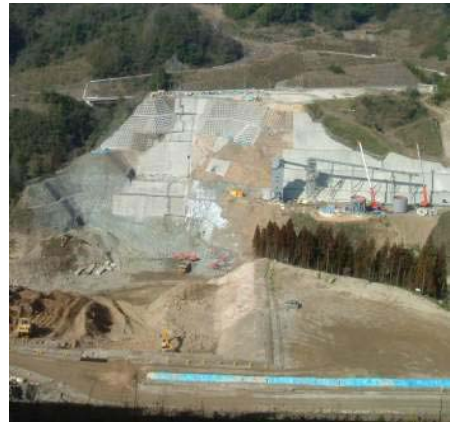
ダム本体掘削状況(左岸より右岸を望む)
