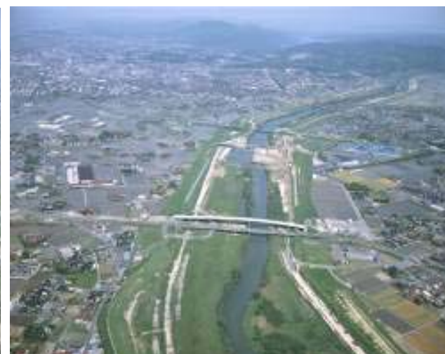
国道9号神戸橋及び神戸堰
