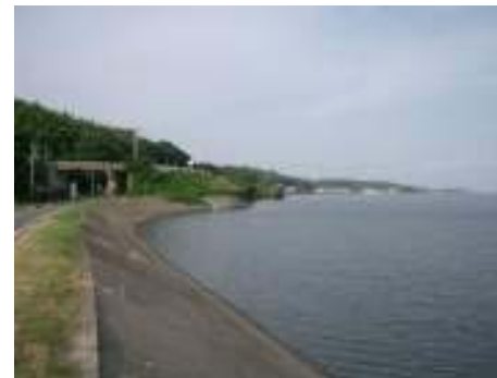
既設湖岸堤の状況
