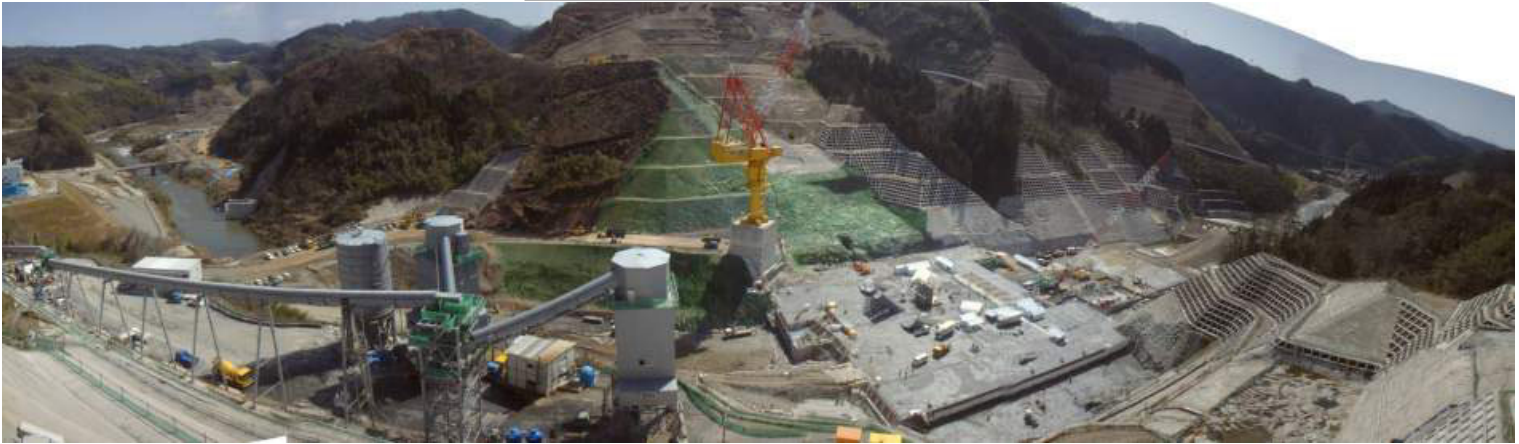
ダム本体施工状況(右岸より左岸を望む)
