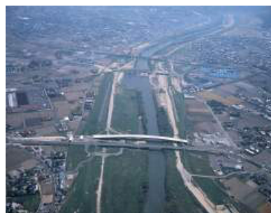
国道9号神戸橋及び神戸堰
