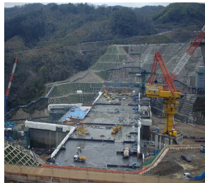
ダム本体施工状況(左岸より右岸を望む)
