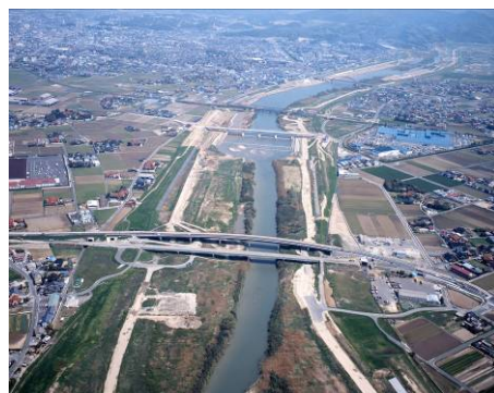
国道9号神戸橋及び神戸堰
