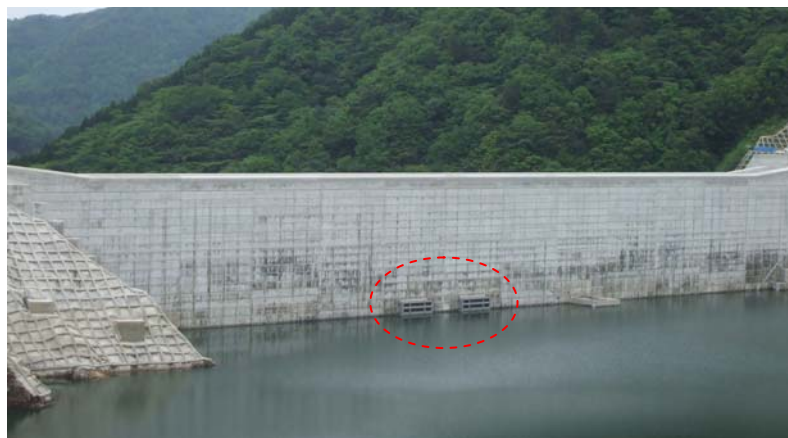
洪水吐き閉塞ゲート撤去前
