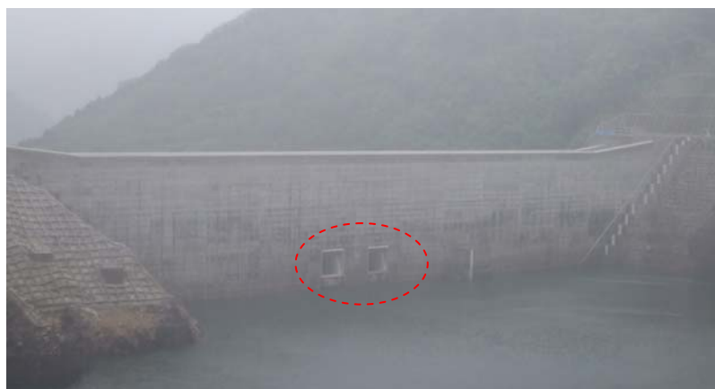
洪水吐き閉塞ゲート撤去後
