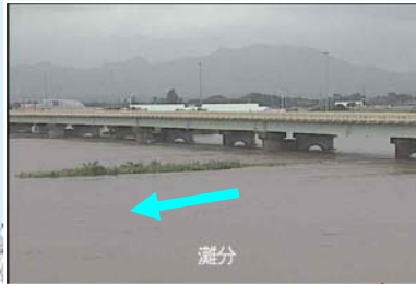
灘分水位観測所 9/3 14時頃
