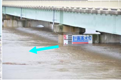
瑞穂大橋左岸側橋脚 9/3 14時頃
