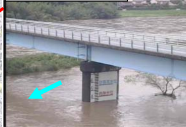
新伊萱水位観測所 9/3 14時頃
