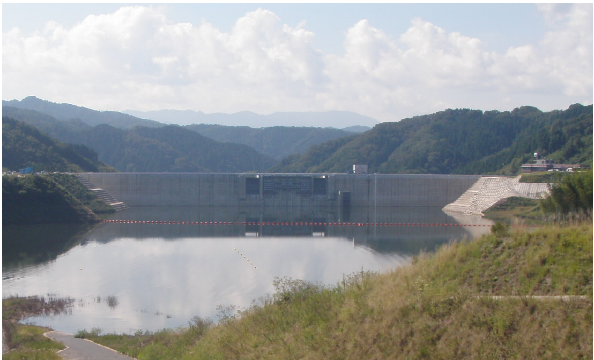
尾原ダム 貯水状況 (撮影:H23.9 末)
