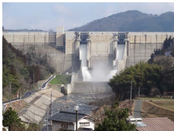
非常用洪水吐きからの試験放流状況（3月4日）
