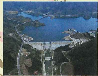
▲尾原ダムとさくらおろち湖
