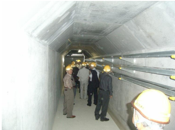
ダム内の通廊を通る見学者
